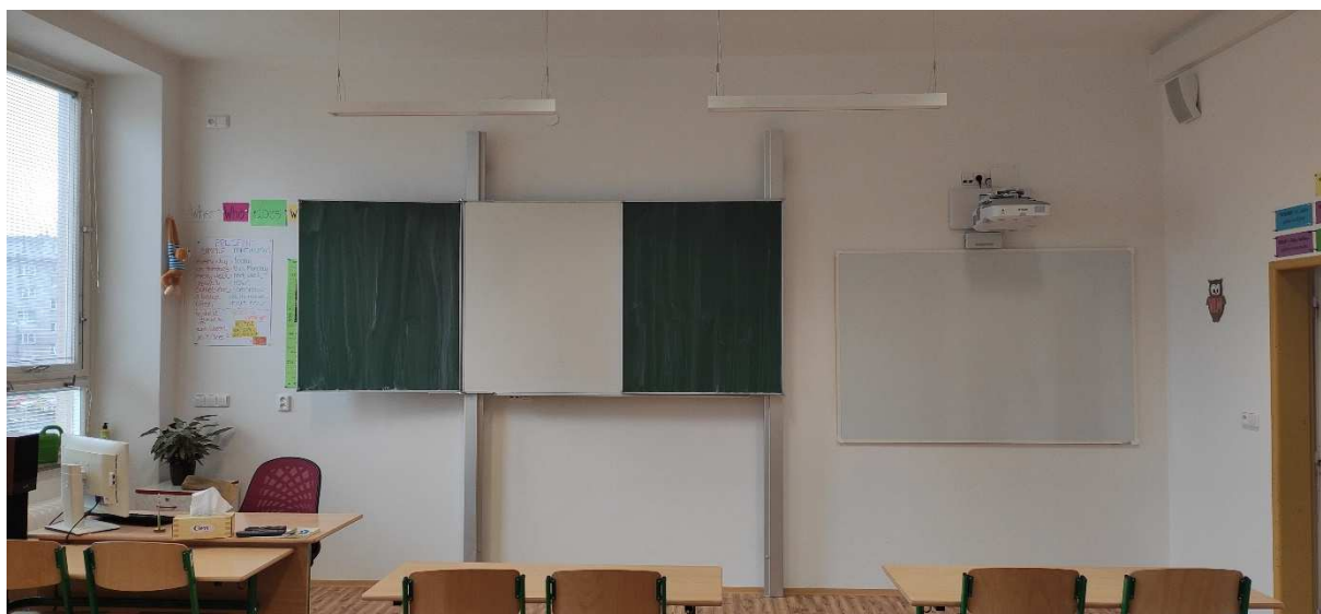
Rekonstrukce elektro 2. NP
