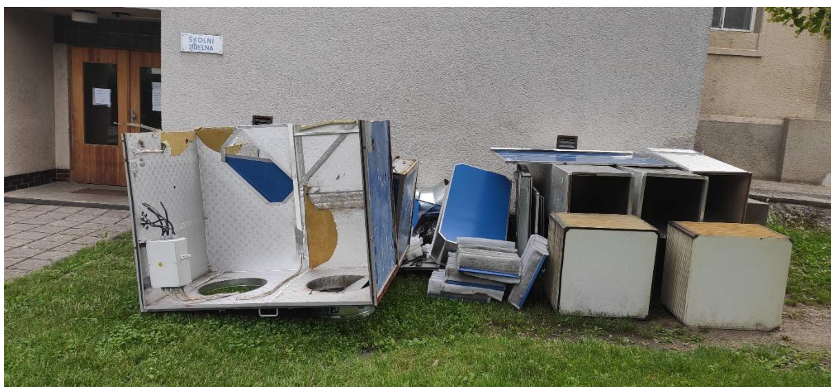
Rekonstrukce vzduchotechniky ve školní kuchyni
