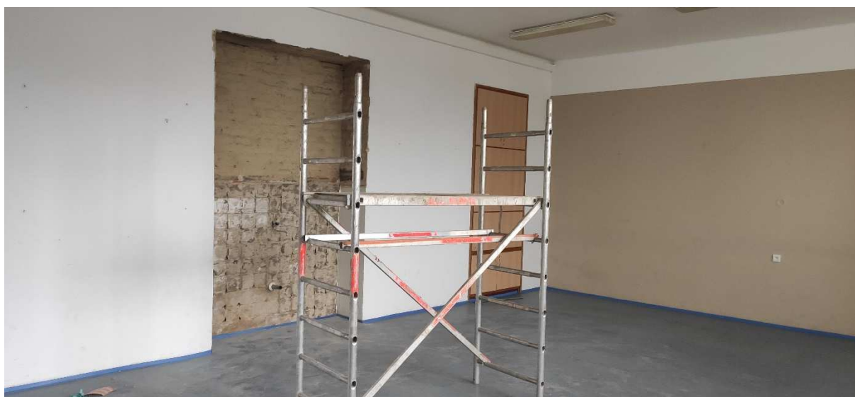
Rekonstrukce elektro 2. NP
