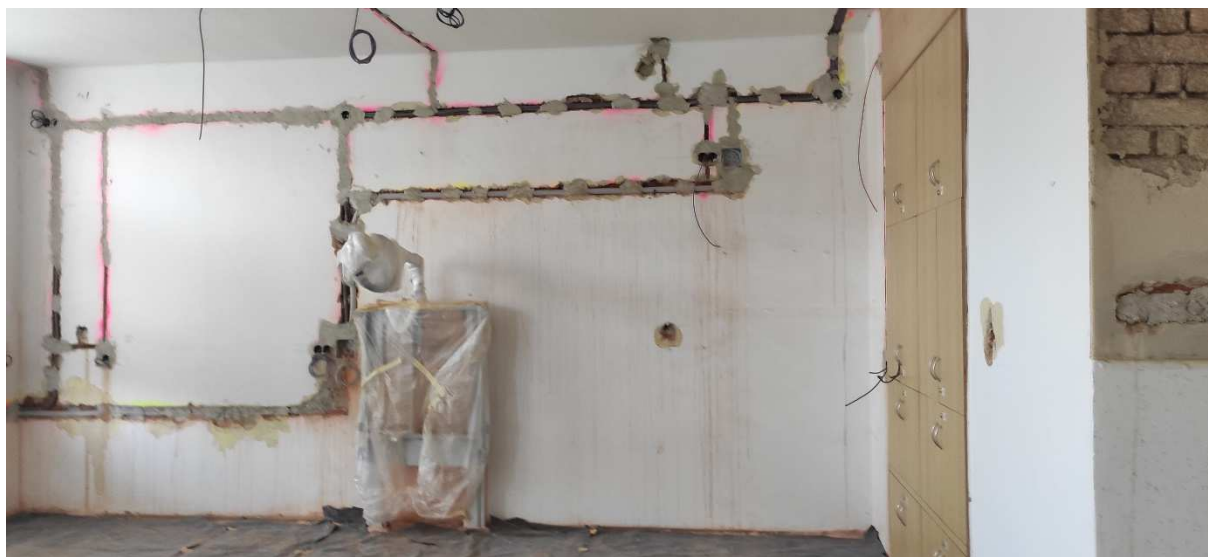
Rekonstrukce elektro 2. NP
