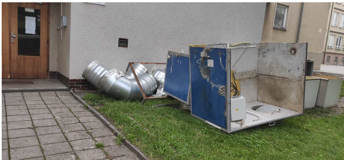
Rekonstrukce vzduchotechniky ve školní kuchyni
