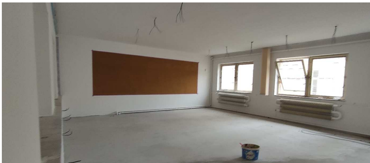
Rekonstrukce učebny výpočetní techniky
